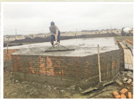
Армированная сейсмоплита 15 см
