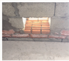
Армированный пояс между этажами
