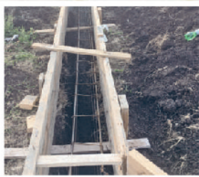
Армированная сейсмоплита 15 см
